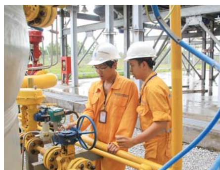
Bảo dưỡng sửa chữa Hệ thống đường ống dẫn khí PM3 - Cà Mau. Ảnh: PV GAS
