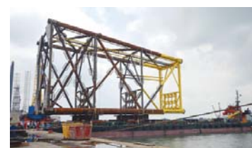
Chân đế giàn Thỏ Trắng 3 được PVC-MS hạ thủy thành công. Ảnh: PVC
